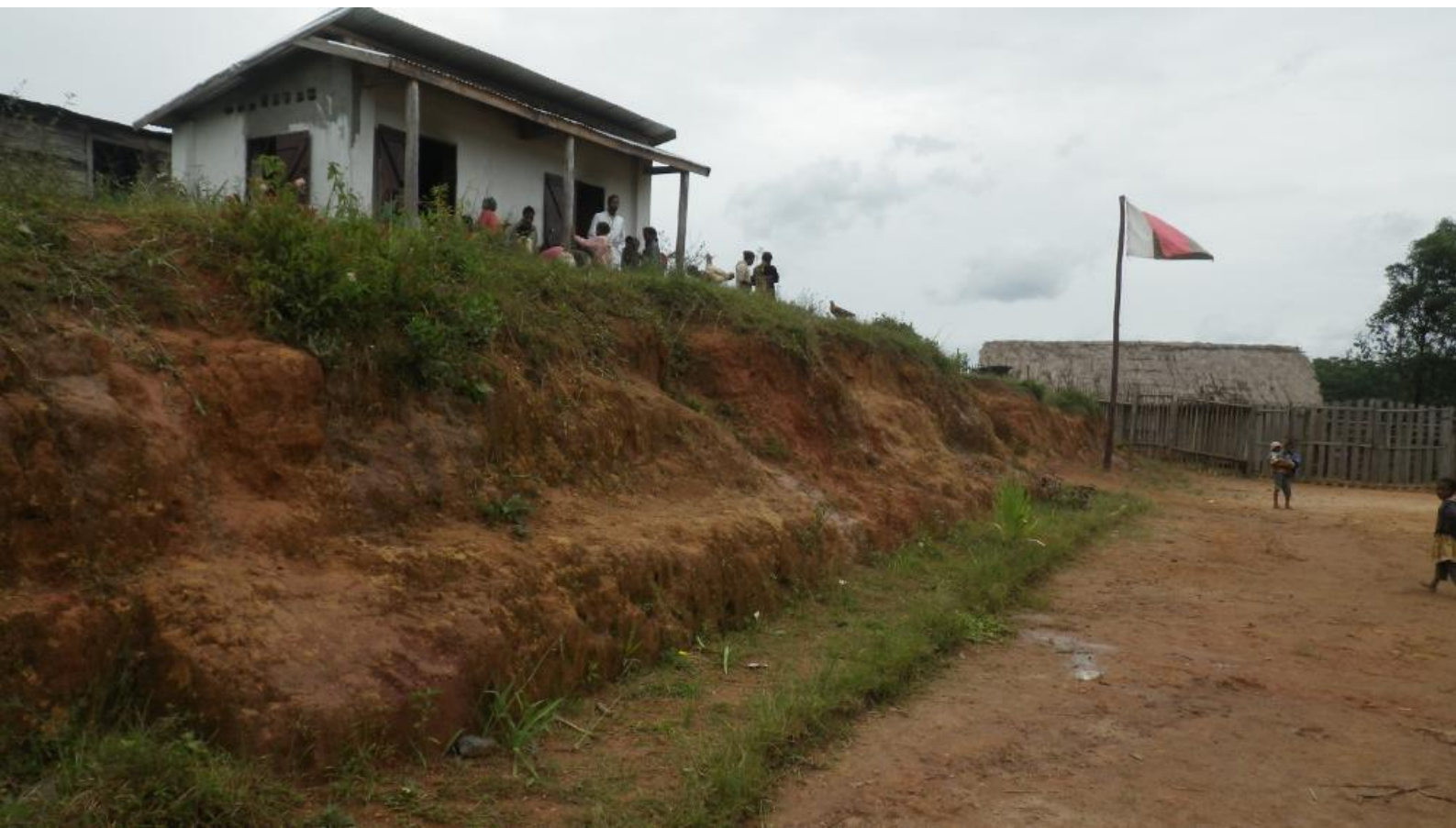
Oben: Der Erosierte nackte Hang vor den Arbeiten.
